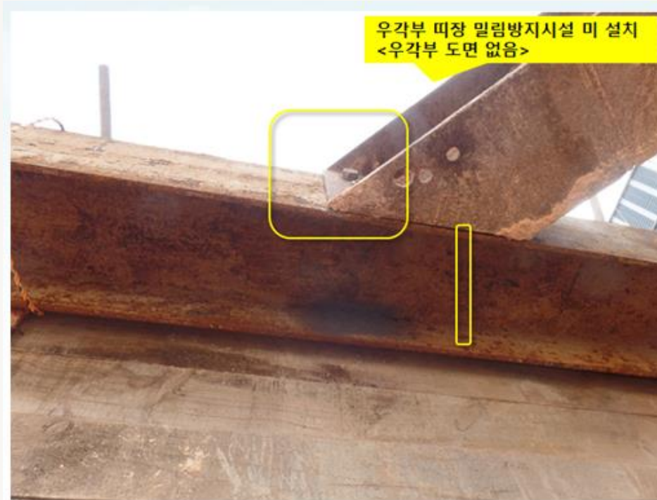
☞ 밀림방지 스톱퍼 설치 및 하부 스티프너 설치
