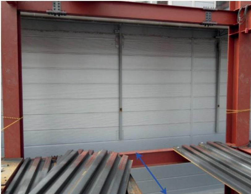
판개작업을 하려던 구간(상부)
